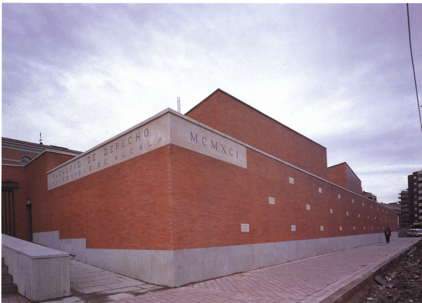
Fachada a la calle Sebastián de la Plaza. Facade of the street Sebastián of the Plaza.
